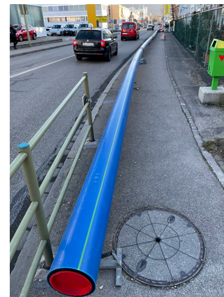
Das neue Rohr ist bereit für den Einzug in das alte Rohr.
