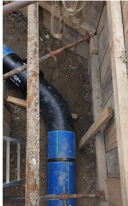
Bogenkonstruktion 45 Grad + «GF» Schweissmuffenverbindungen
