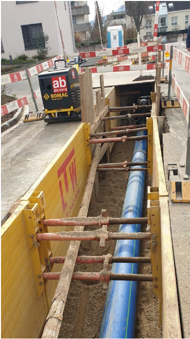
Eine weitere Etappe ist bereit für die Druckprüfung.
