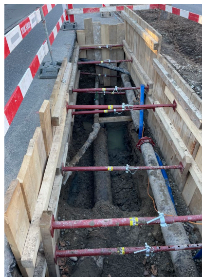
Teilweise wurde die Transportleitung mittels Relining-Verfahren saniert.
